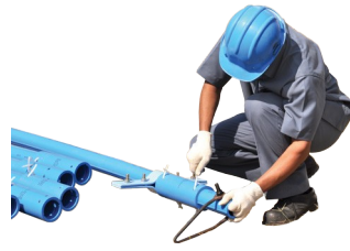
5 - Préparer les colonnes pour la descente
