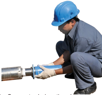
1 - Connecter la jonction de pompe avec la pompe
