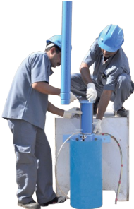
4 - Monter l'accessoire de protection de la pompe
