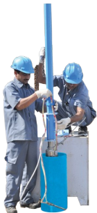
7 - Accrocher les câbles de pompe en utilisant les clips prévus à cet effet
